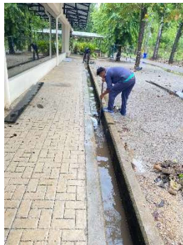
การขุดลอกรางระบายน้ำฝนภายในโรงงาน
