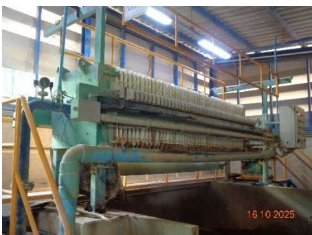
ภาพที่ 2-22 เครื่องอัดตะกอน จากระบบบำบัดน้ำเสีย
