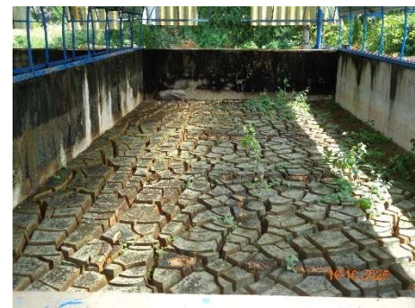
ภาพที่ 2-21 ลานตากตะกอน จากระบบบำบัดน้ำเสีย
