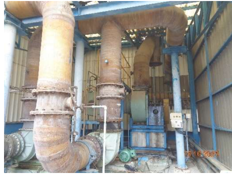
ภาพที่ 2-2 Lamellar Mist Separator
