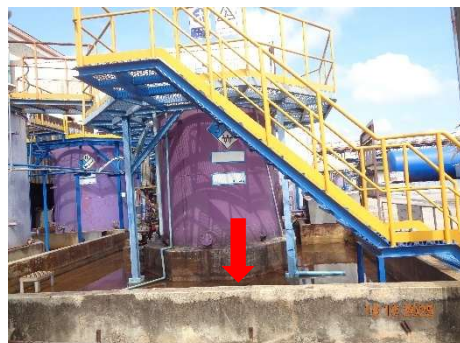
ภาพที่ 2-29 คันกั้นบริเวณพื้นที่ตั้ง ถังบรรจุสารเคมีที่เป็นของเหลว ( H_2SO_4 )
